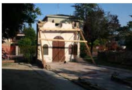
L'oratoire après les relevés, la fouille des parties écroulées et mise en sécurité de la façade, travaux réalisés par des bénévoles guidés par des archéologues.
