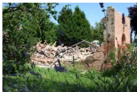
L'oratoire de Sainte-Anne après le séisme du 29 mai. L'ensemble de la nef s'est effondré sous le poids d'un toit alourdi par une restauration en béton. Seule une partie de la façade est encore debout.
