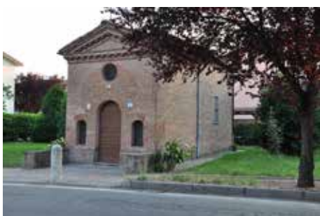
L'oratoire de Sainte-Anne dans l'état précédant le séisme.
